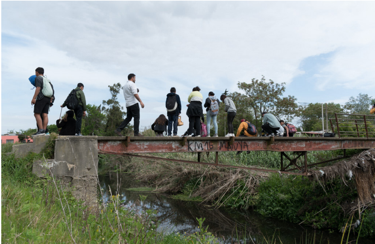
Figura 5 - Foto Recorrida con estudiantes de la UTU sobre puente peatonal en el arroyo Manga. Autoría Florencia Vignale.
