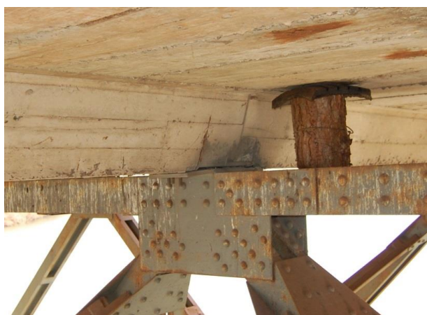
Fig. 5. Tacos metálicos provisionarios
