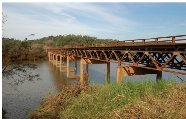
Fig. 1. Vista lateral del puente.
