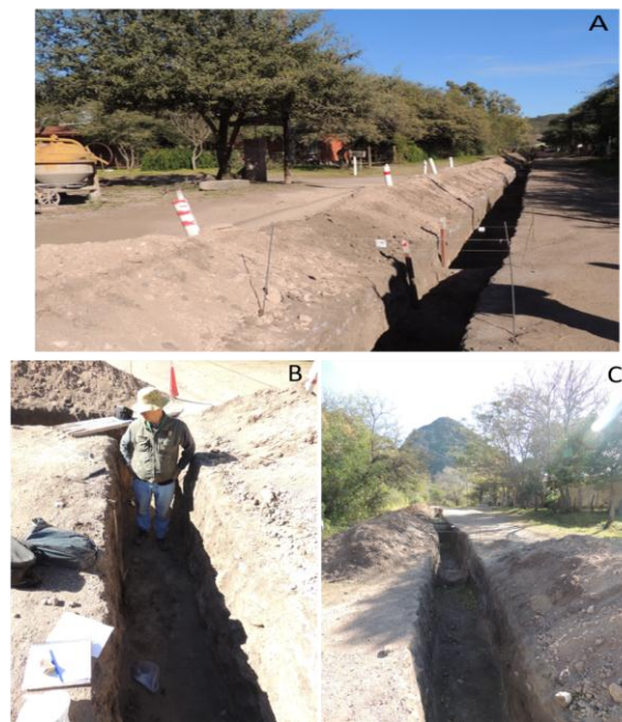
Fig. 3: Zanja excavada de apertura temporaria. A. Sector de la zanja con mayor longitud sobre calle Tulumba (Tramos 1 y 2). B. Zona de intersección entre calles Tulumba y Córdoba (Tramo 2). C. Sector con menor longitud sobre calle Córdoba donde la pendiente se incrementa en dirección al arroyo Los Tártagos (Tramo 3).
