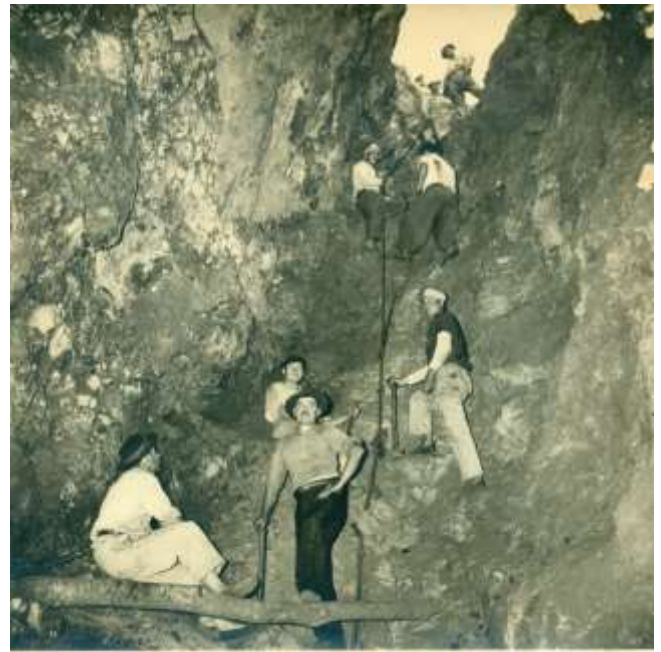
Fig. 8: Mina Hiermang (manganeso). Foto gentileza de José Luis Cámara.
