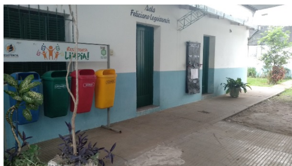
Figura 1. Fachada de la biblioteca
