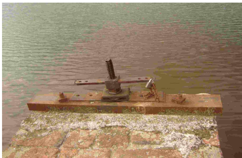
Figura 20: Compuerta de Salida ubicada sobre el muro aguas arriba. Vista de la descarga por el conducto de salida.
