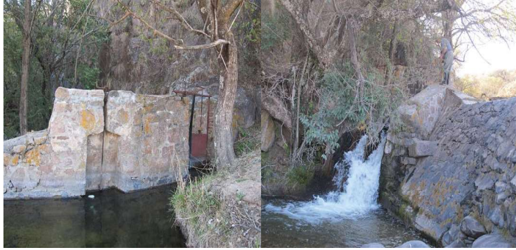
Figura 11: Obra de toma: Desarenador y compuerta de Santa Catalina.
