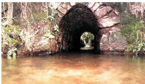
Figura 15: Vista de un tramo de acequia abovedada y revestida
