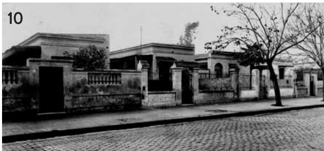
Figura 10. Casas del Hogar Obrero en Liniers 114.
