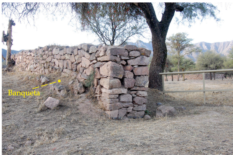
Figura 5: El muro segmentado, donde puede observarse una de las banquetas. (Foto: Gustavo Corrado).
