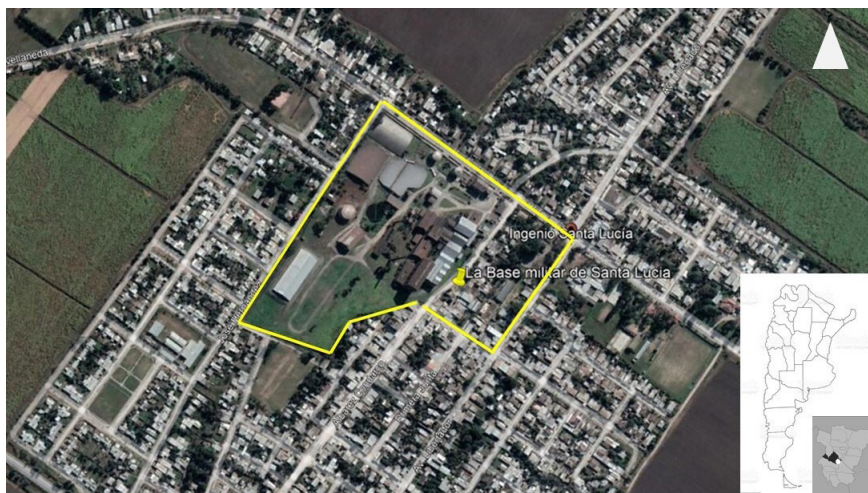
Figura 1. Imagen google Earth. Diciembre 2021. En amarillo se encuentra delimitado el predio del ex Ingenio Santa Lucía. La flecha marca el edificio de TUC-SL2.
