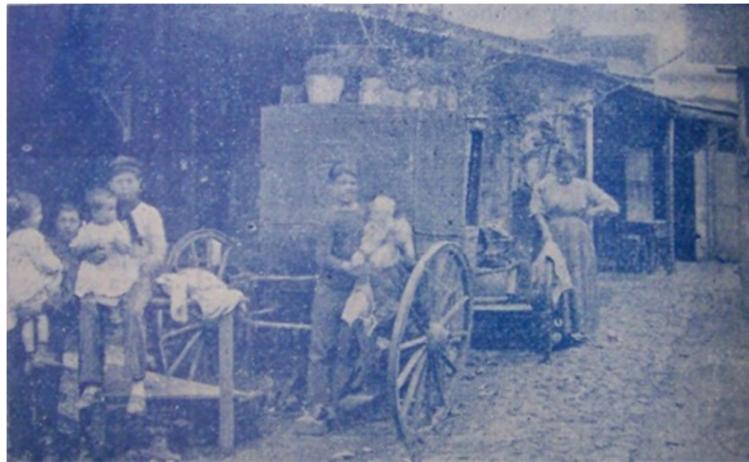
Figura II. Patio de conventillo mendocino
