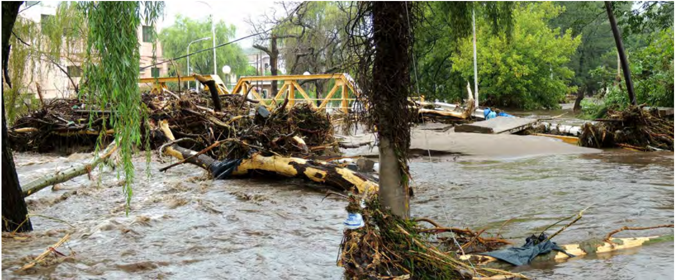
Figura 2. La imagen muestra cómo un puente mal ubicado se convirtió en un obstáculo que retuvo los materiales arrastrados por la crecida, represando el agua que se desbordó por los laterales (e incluso le pasó por encima) inundando un amplio sector del centro de la localidad de Río Ceballos.
