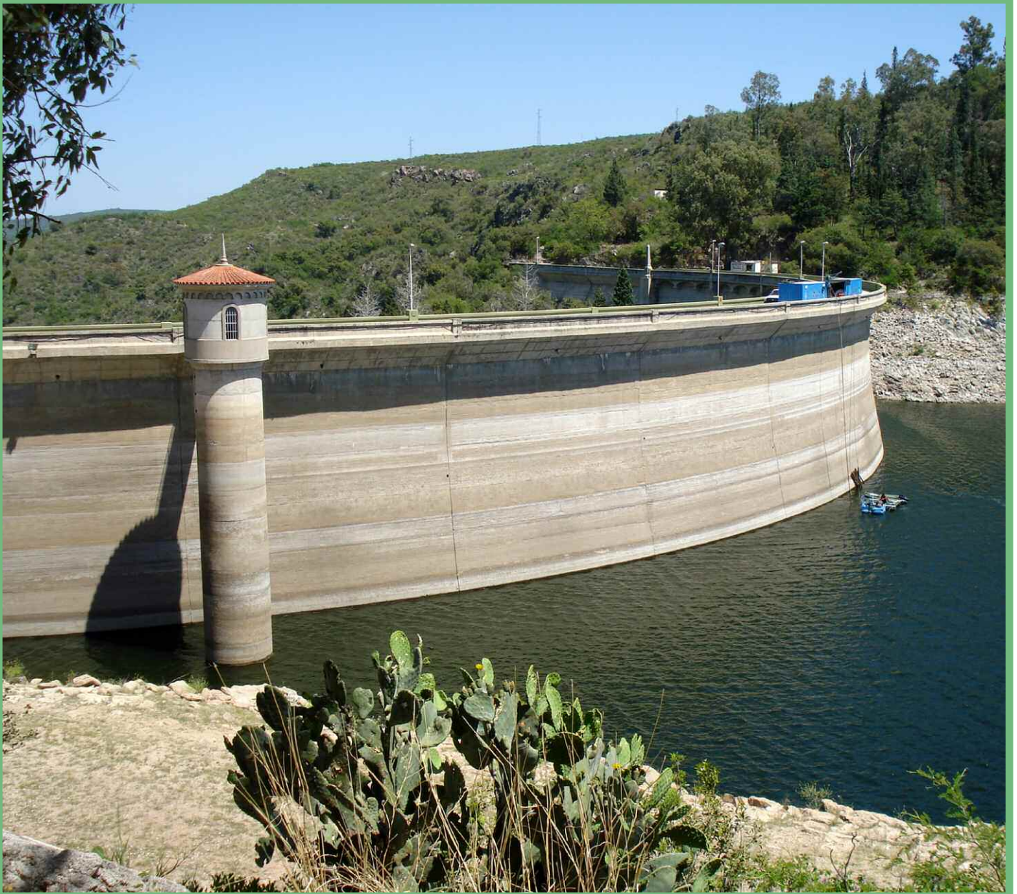
Dique La Viña, departamento San Alberto, Provincia de Córdoba
