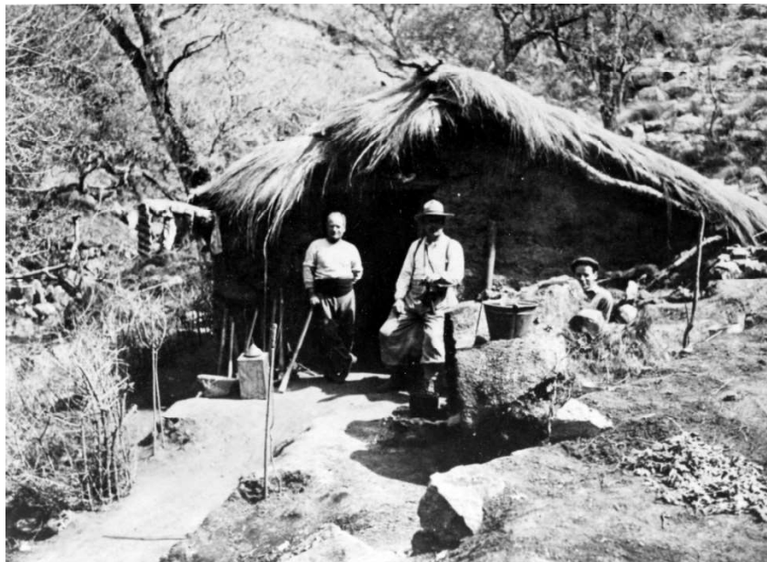
Figura 3a. Primeras edificaciones de Mina Dal. Peralta Martínez (1944), Archivo Servicio Geológico Minero Argentino (SEGEMAR).
