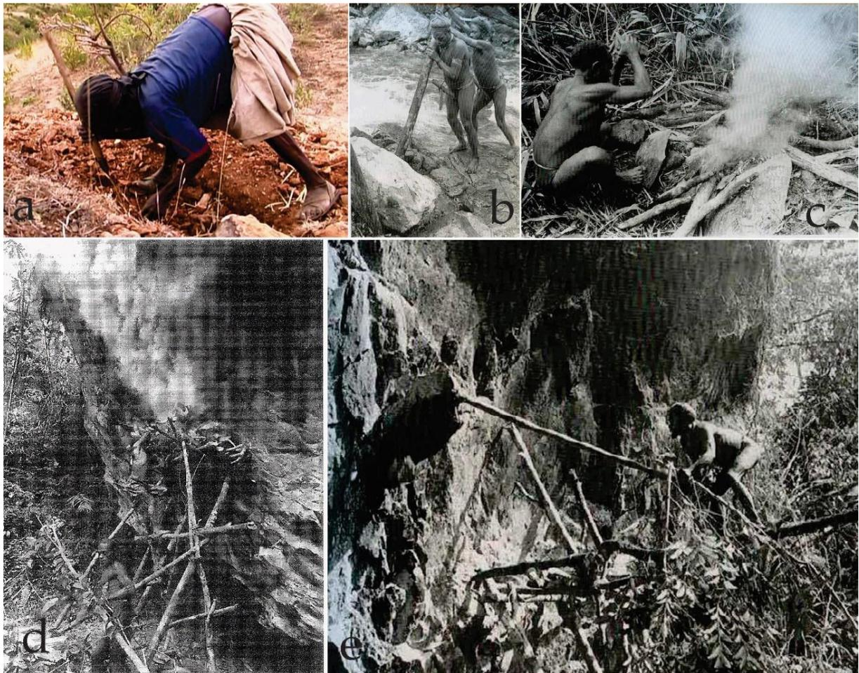
Figura 2. Implementos empleados en la fragmentación y obtención de rocas. a) Utilización de palo cavador (Tomado de Belking 2006); b y e) Empleo de barretas y palancas de madera para remover grandes bloques y fragmentos de rocas agrietados (tomado de Pétrequin y Pétrequin 2000); c y d) Aplicación de fuego sobre nódulos y paredes laterales de grandes filones, sobre andamios (Tomado de Pétrequin *et al.* 2000; Pétrequin y Pétrequin 2000).
