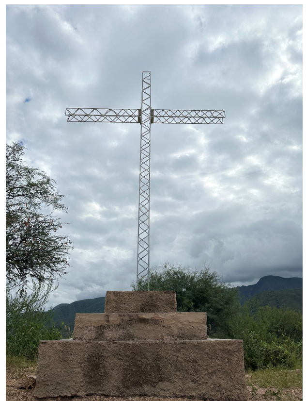
Figura 6. Base de la cruz como estación final del Vía Crucis en la Cima 1 de Loma Larga. (Fotografía de Lic. Milagros Aventín Moretti).
