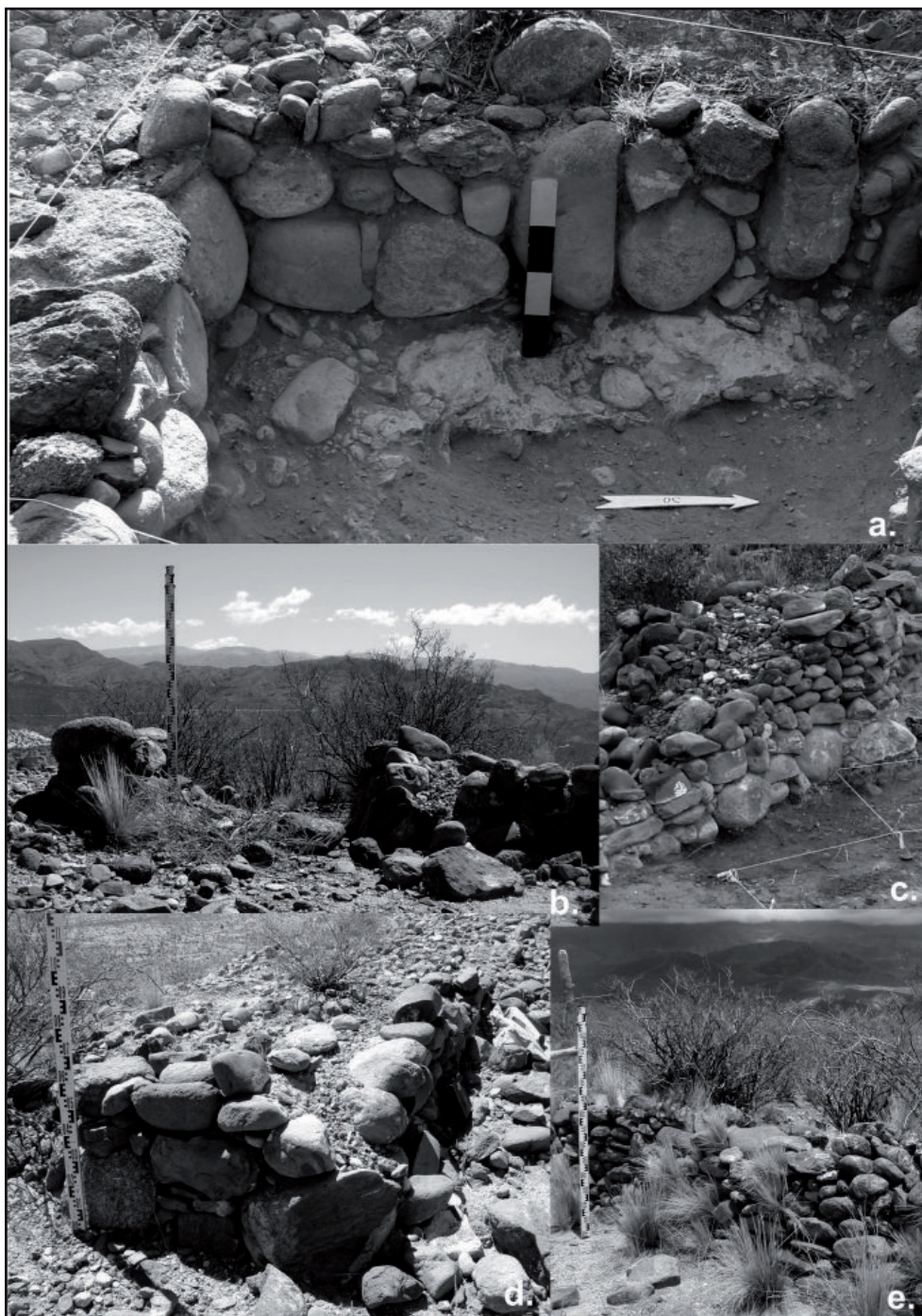
Figura 4. Rasgos arquitectónicos. a. detalle de muro, se observa la posición de piedras, cuñas y apoyo en cimientos. b. entrada a uno de los recintos. c. muro doble. d. entrada, nótese el ancho del muro doble que forma un pequeño pasillo. e. muro con buen estado de conservación.
