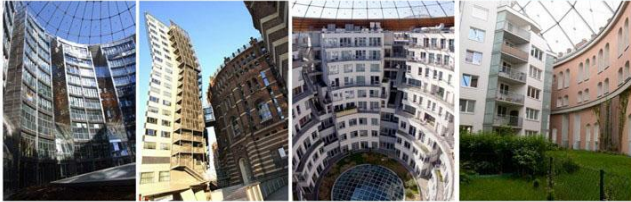
Los gasómetros de Viena
