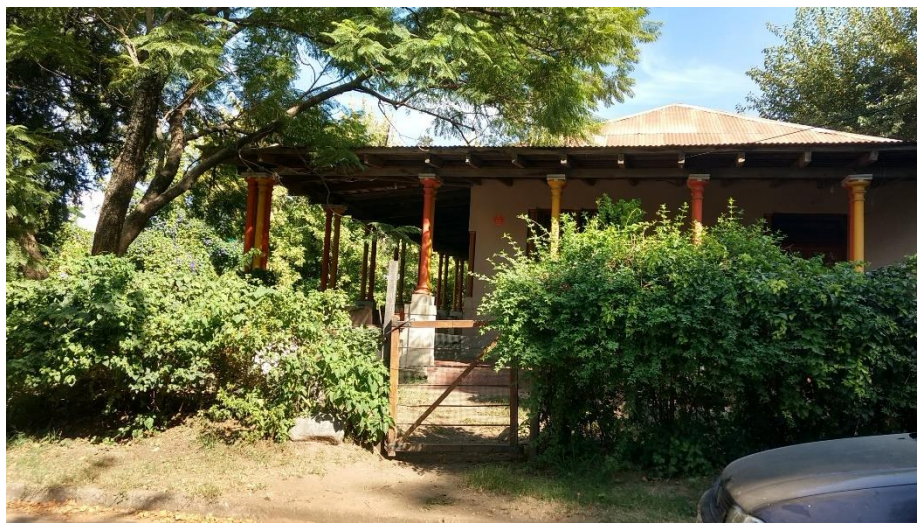
FIGURA 9: Casa de las Columnas - Arq. C.A.Ferrari. Autor: Juan Manuel Bergallo.
