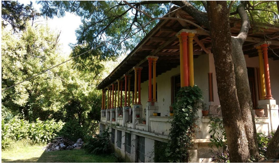
FIGURA 10: Casa de las Columnas - Arq. C.A.Ferrari. Autor: Juan Manuel Bergallo .
