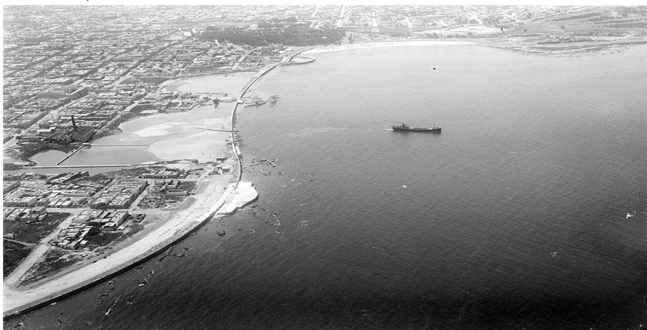
Figura 1: Rambla Sur. Vista aérea de las playas de Santa Ana y Patricio durante las obras de drenaje y relleno para la construcción de la Rambla Sur, 1930.
