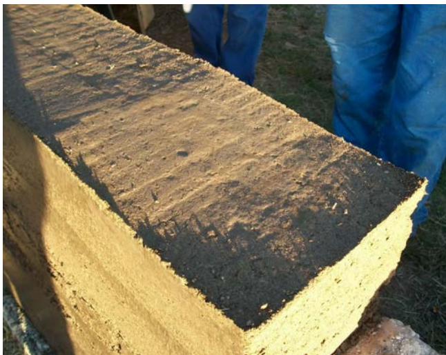
Tapia de 30 cm. de espesor
