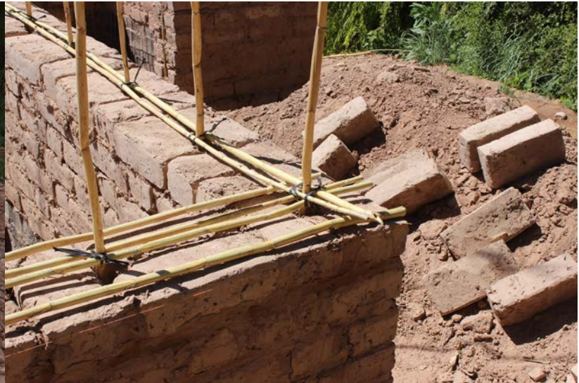
Aplicación de las recomendaciones de la NT E.080 en Maimará, provincia de Jujuy
