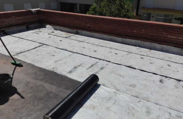
Finalmente se completa la cubierta con una aislación hidrófuga + placas de poliestireno expandido + una capa de piedra partida, conformando una cubierta invertida de excelente funcionamiento bioclimático.
