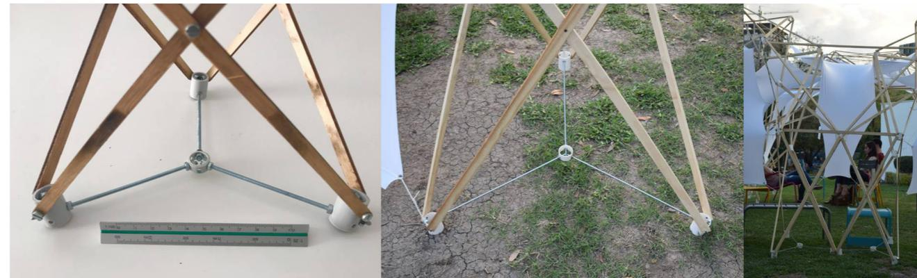
DETALLE CONSTRUCTIVO PARA LAS ARTICULACIONES COMPUESTAS Y LOS SISTEMAS DE BLOQUEO DE MOVIMIENTO
