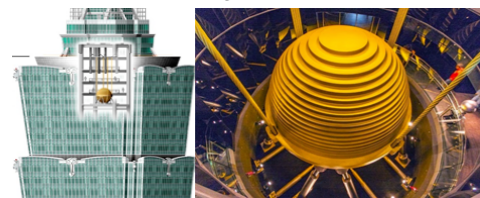
Amortiguador de masa sintonizada. Taipei 101. Esquema (izquierda) Péndulo y amortiguadores viscosos (derecha) ( https://arquitectl.blogspot.com/2014/08/taipei.html )
