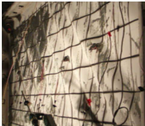
Muro de acero al finalizar el ensayo cíclico
