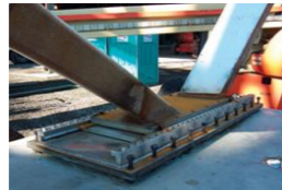
Deslizador con teflón del Aeropuerto de Mineta, C.A. www.structure.org
