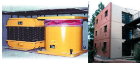
Vista exterior del edificio de Residencia Universitaria de la UTN de la FRM y sistemas de aisladores de resortes y amortiguador viscoelásticos ubicados en la interfase entre la superestructura y su fundación. www.gerb.com
