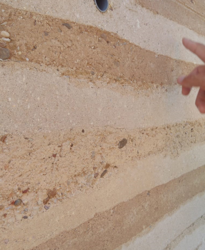
Muro de tapia. Amayuela de Abajo, España. Colaboración del Ing. Santiago Cabrera, UTN, Sta. Fe
