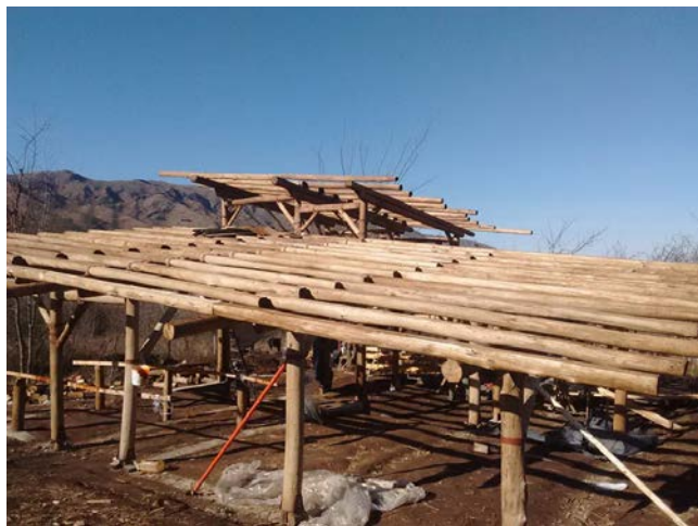
DETALLE UNIÓN COLUMNAS Y VIGAS EN VISTA
