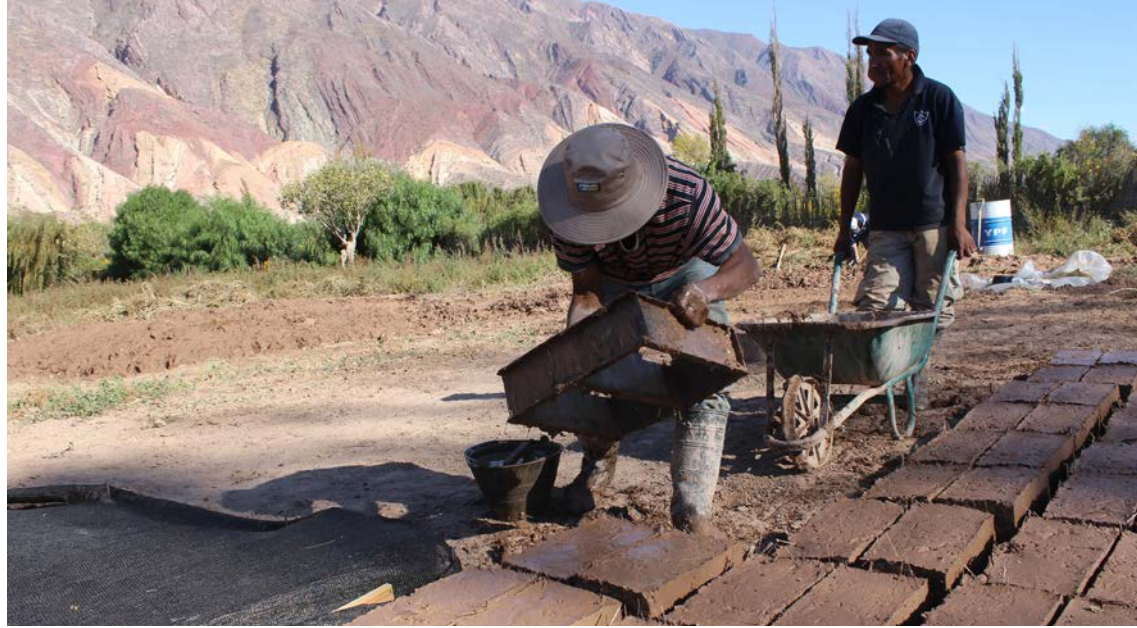
Proceso de fabricación de adobe en Jujuy
