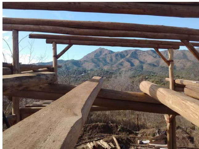
DETALLE UNIÓN COLUMNAS Y VIGAS EN PLANTA
