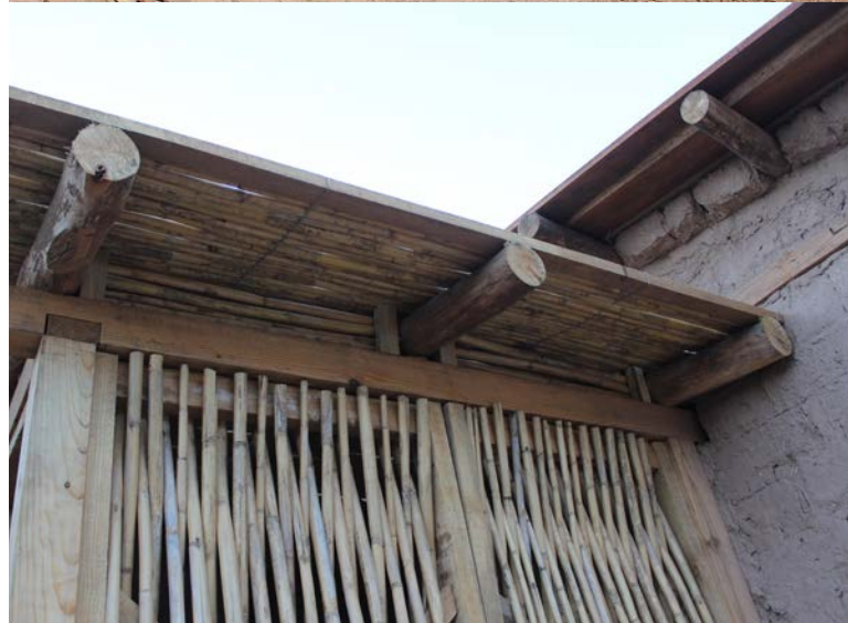
Detalles de construcciones con quincha reforzada
