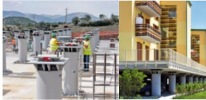
Aislador de péndulo "Isoslab System" (Freyssinet y Studio Calvi). Edificio con planta baja de cocheras aislado.
