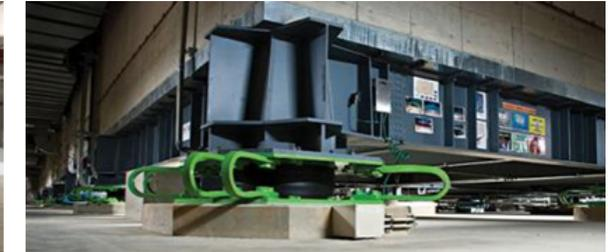
Hospital Ishinomaki de la Cruz Roja con un sistema aislamiento-disipación. La superestructura de hormigón armado se apoya en un chasis de vigas de acero sobre aisladores de neopreno. Las piezas verdes en forma de "U" son disipadores adicionales.
