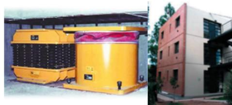
Vista exterior del edificio de Residencia Universitaria de la UTN de la FRM y sistemas de aisladores de resortes y amortiguador viscoelásticos ubicados en la interface entre la superestructura y su fundación.
