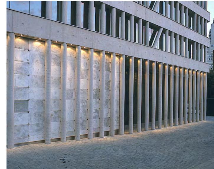
La viga perimetral se ubica de manera invertida, conformando un antepecho junto al cual se ubican los ductos de climatización y electricidad. Esta viga se apoya sobre pilares cilíndricos que mantienen su sección en toda la altura del edificio y aumentan su cantidad según la magnitud de la carga gravitatoria. Estos elementos conforman una fachada y plano resistente vertical con un diseño centrado en la expresividad de la estructura, colocada por fuera del cerramiento.
