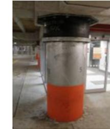
Aislador elastomérico en el capitel de una columna de acero en el subsuelo de un edificio.
