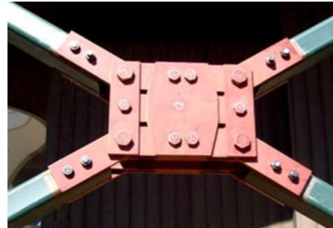
Disipador por fricción tipo Pall. Rehabilitación de un edificio de 14 pisos (Shao, Pall y Soli, 2012)
