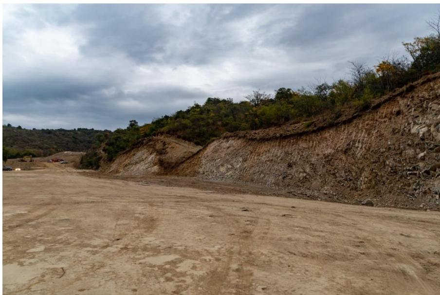
Avance de las obras de la autovía sobre la ruta provincial 5. (Foto Pablo Sigismondi)
