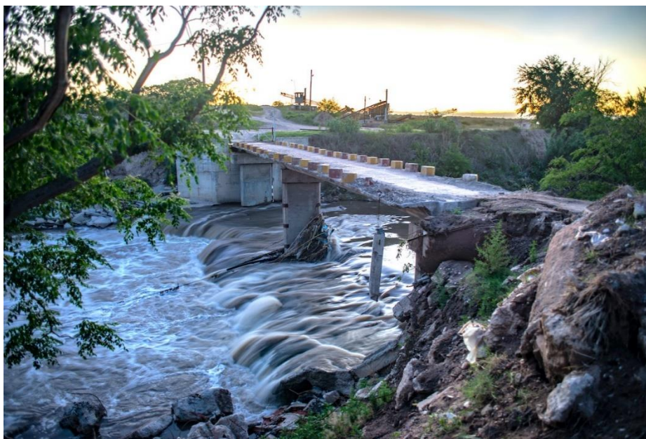
Puente Tegli sobre el río Suquia (Foto Pablo Sigismondi)
