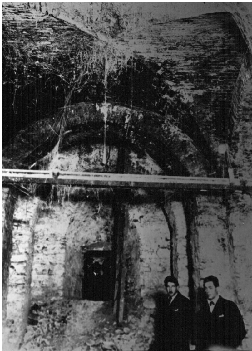
Fig. 4. La cripta convertida en sótano antes de 1928, conservando sus bóvedas.
