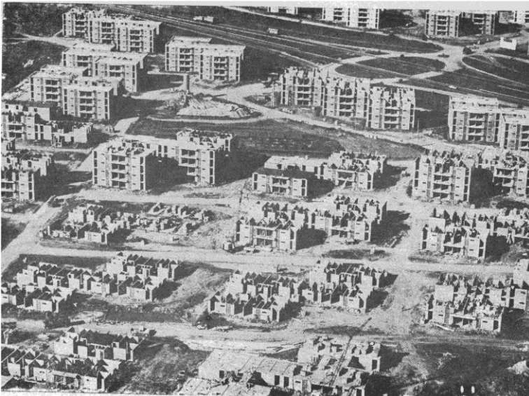
Imagen 4 Conjunto de viviendas Barrio Rucci
