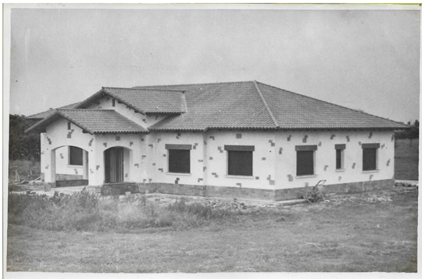
Foto 8: Casa del director, construcción aislada tipo chalet californiano, 1954. Fuente: Archivo DNA
