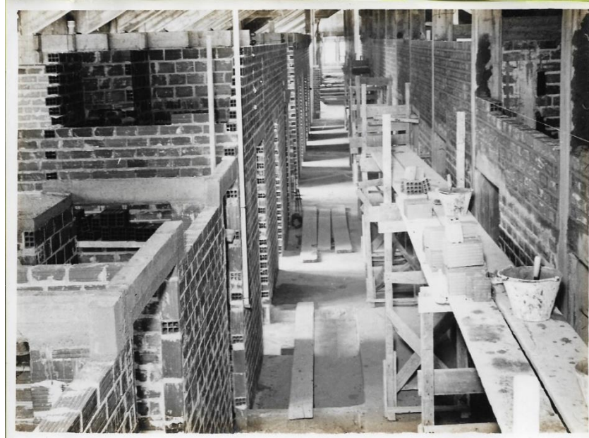
Foto 9. Proceso de obra del Hospital Policlínico diciembre 1953. Fuente: Archivo DNA
