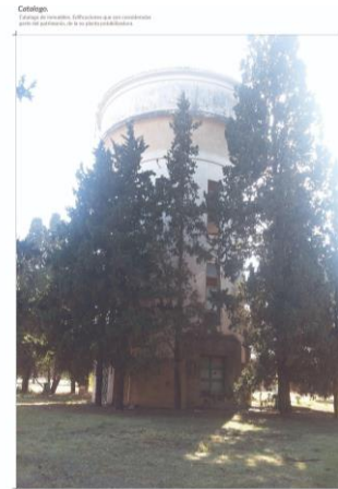
F12.SITIO. Catálogo de inmuebles. Tanque de base circular.
