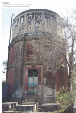
F12.SITIO. Catálogo de inmuebles. Tanque de base octogonal.
