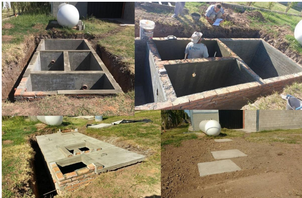
Figura 6: Fotos de la construcción de la cámara séptica en el PAER Rafaela
