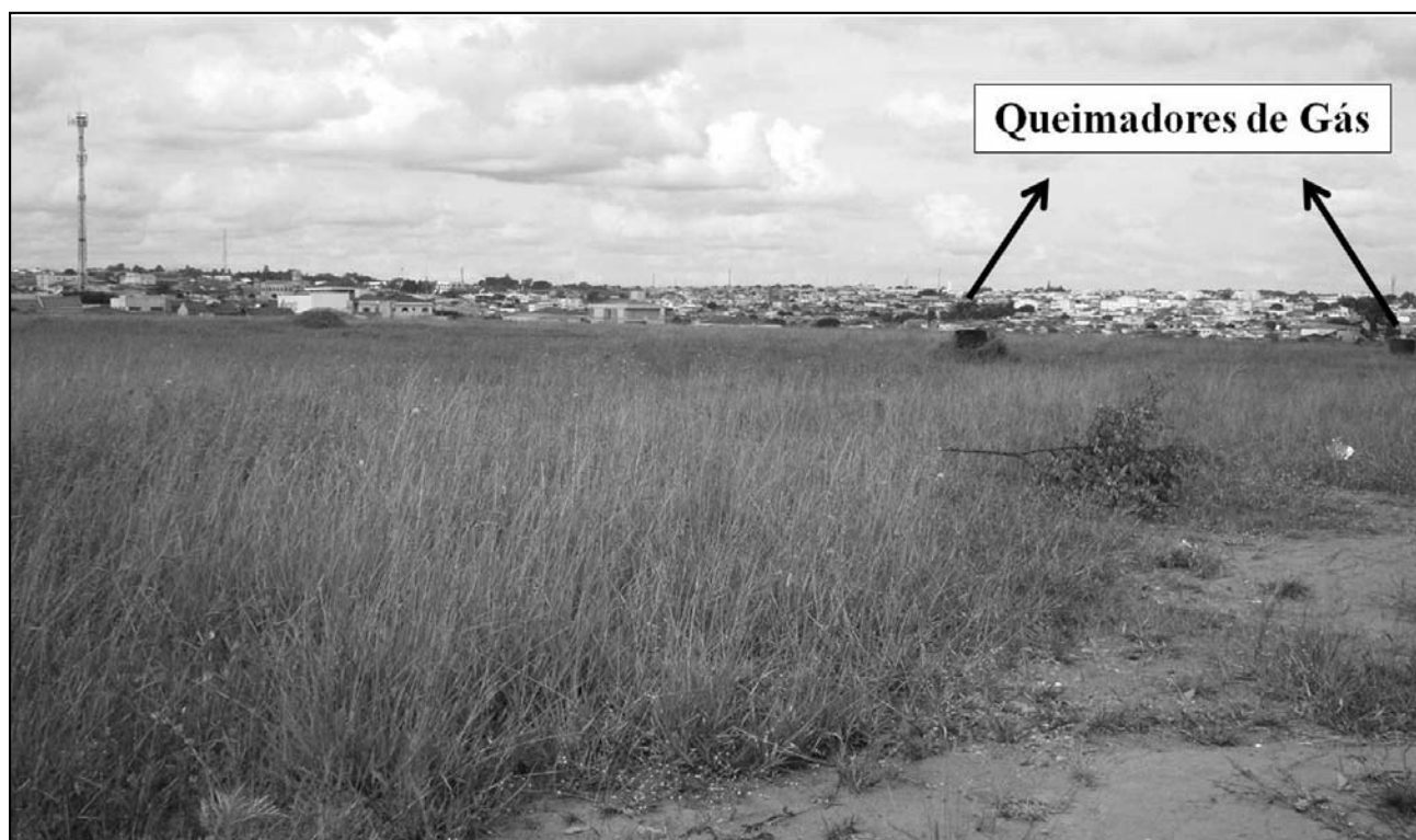
Figura 14. Configuração atual da Área 4, com detalhe de antigos queimadores de gás do aterro sanitário.
