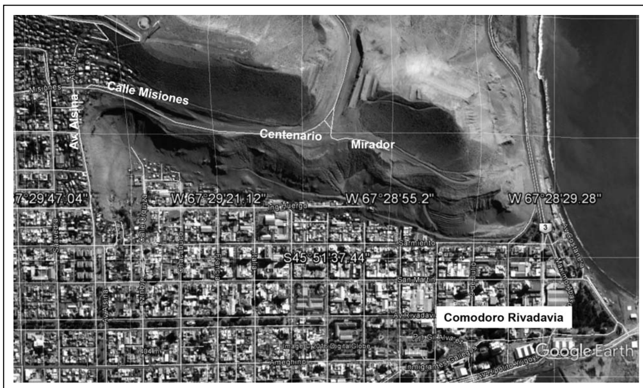
Figura 2. Vista del faldeo sur del cerro Chenque previo a la intervención proyectada (imagen satelital capturada el 24 de febrero de 2011).
