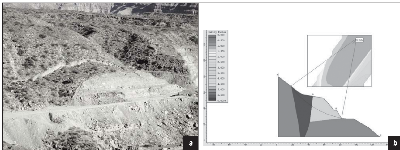
Figura 12. a) Vista de un deslizamiento circular y b) modelación de la estabilidad.
