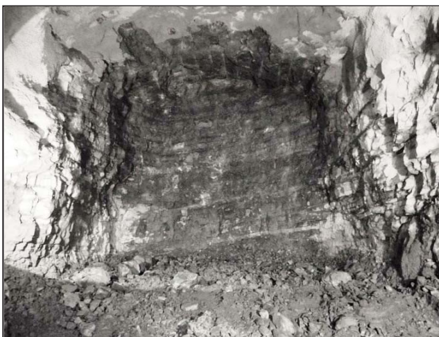
Figura 14. disposición de pelitas del frente de excavación.
