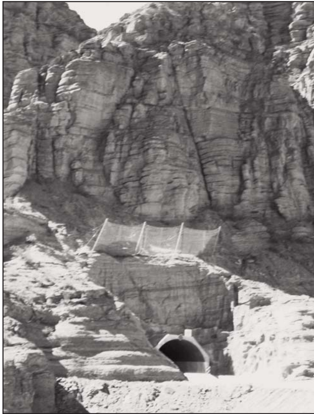
Figura 10. Mitigación de caída de bloques en los portales de salida del T5, con barreras dinámicas.
