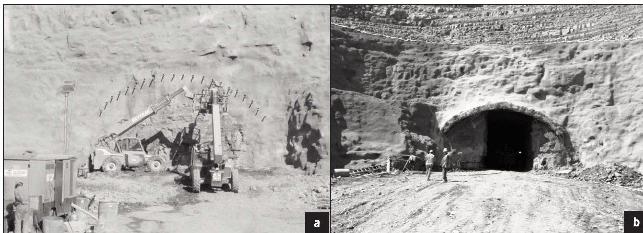
Figura 3. a) Ejecución de paraguas de micropilotes. b) Viga de vinculación del paraguas.
