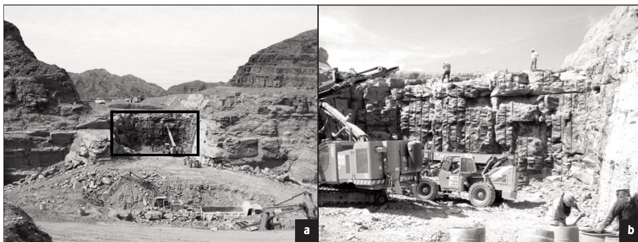
Figura 7. a) Vista de fundación del estribo y b) detalle recuadrado de base del puente arco A2 sobre el río Agua de la Peña.
