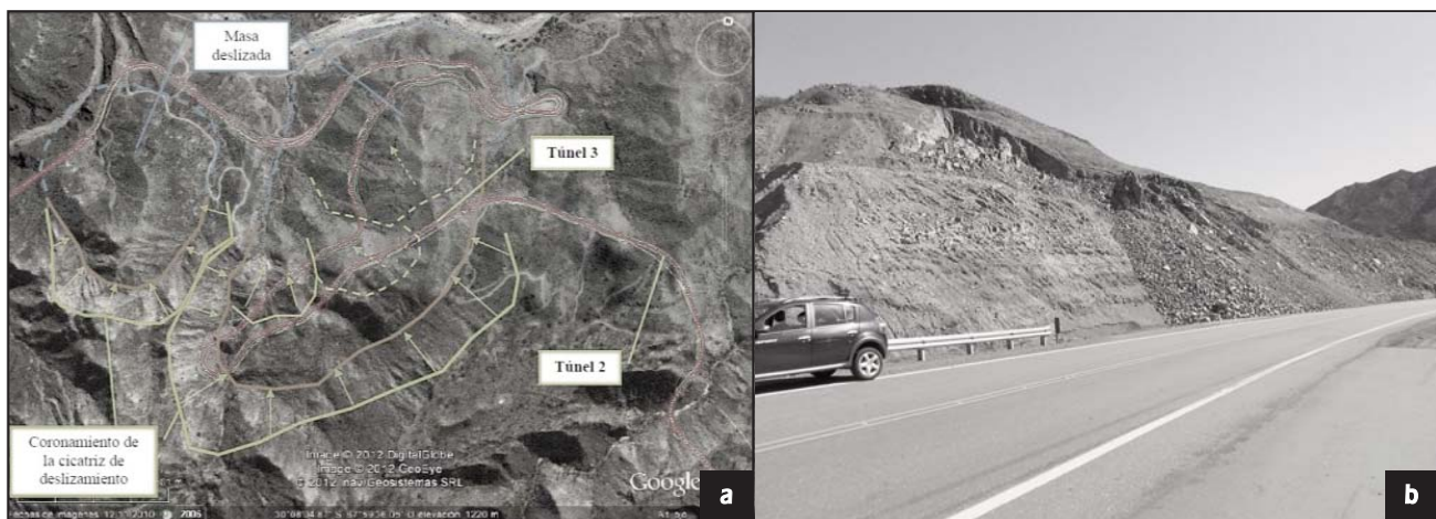
Figura 11. En a) se observan paleodeslizamientos, mientras que en b) se presenta uno reciente.
