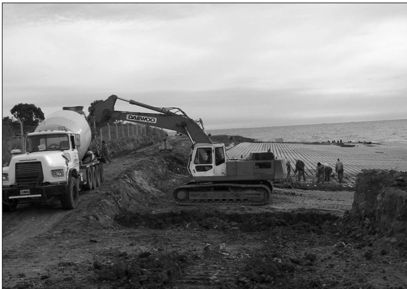
Figura 6. Construcción de paredones inclinados con bloques premoldeados de hormigón, en el sector norte de la Ciudad Universitaria.
