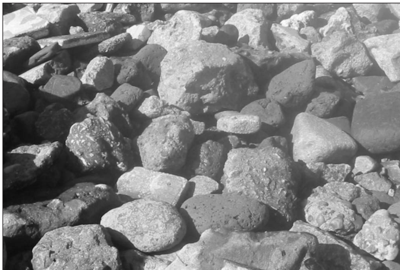
Figura 8. Detalle de la composición de la playa desarrollada con el material aportado para relleno.
