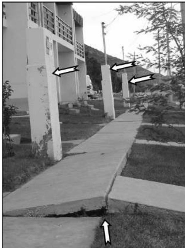
Se relevaron importantes roturas por hundimiento en la vereda perimetral de las viviendas 13 y 14, en el cerco sureste de la 13 con un descenso de 20 cm. (provocando la rotura de las cañerías de agua y gas) y patio posterior de la 14, de hasta 15 cm. La concentración de hundimientos se halla vinculada al fracturamiento del terreno (Figura 7) de carácter regional, a partir del plano de deslizamiento y a las pérdidas de agua asociadas.
