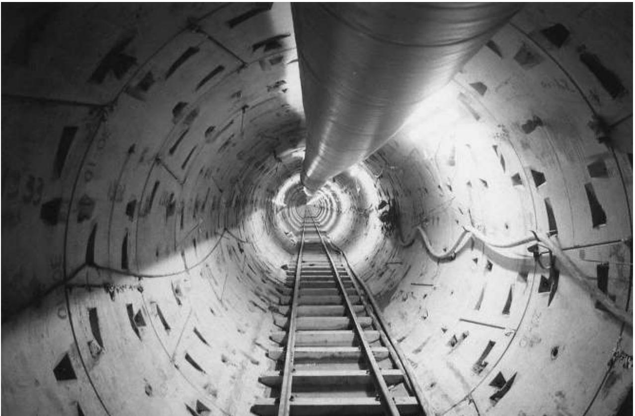
**FIGURA 7. TÚNEL DE 4,40 MTS. SALIDA DE LA MÁQUINA TUNELADORA EN EL POZO DE MANIOBRAS.**
