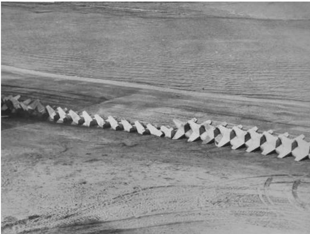
pérdida de los espacios de playa, se procedió a ejecutar una obra, constituida por la colocación de una hilera de tetrápodos de hormigón de 2 toneladas de peso promedio, conformando una línea paralela a la costa en el sector de playa distal (figura 3) o el pie de duna con el objeto de evitar así el retroceso de la línea de costa. Este tipo de obra es recomendada para defender la base de los
