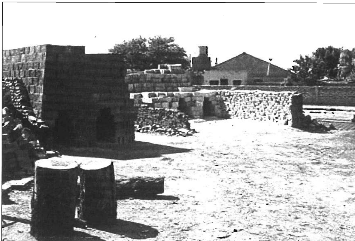
FIGURA N° 4. OTRA VISTA DE HORNOS DE DON VALERIO SOSA
