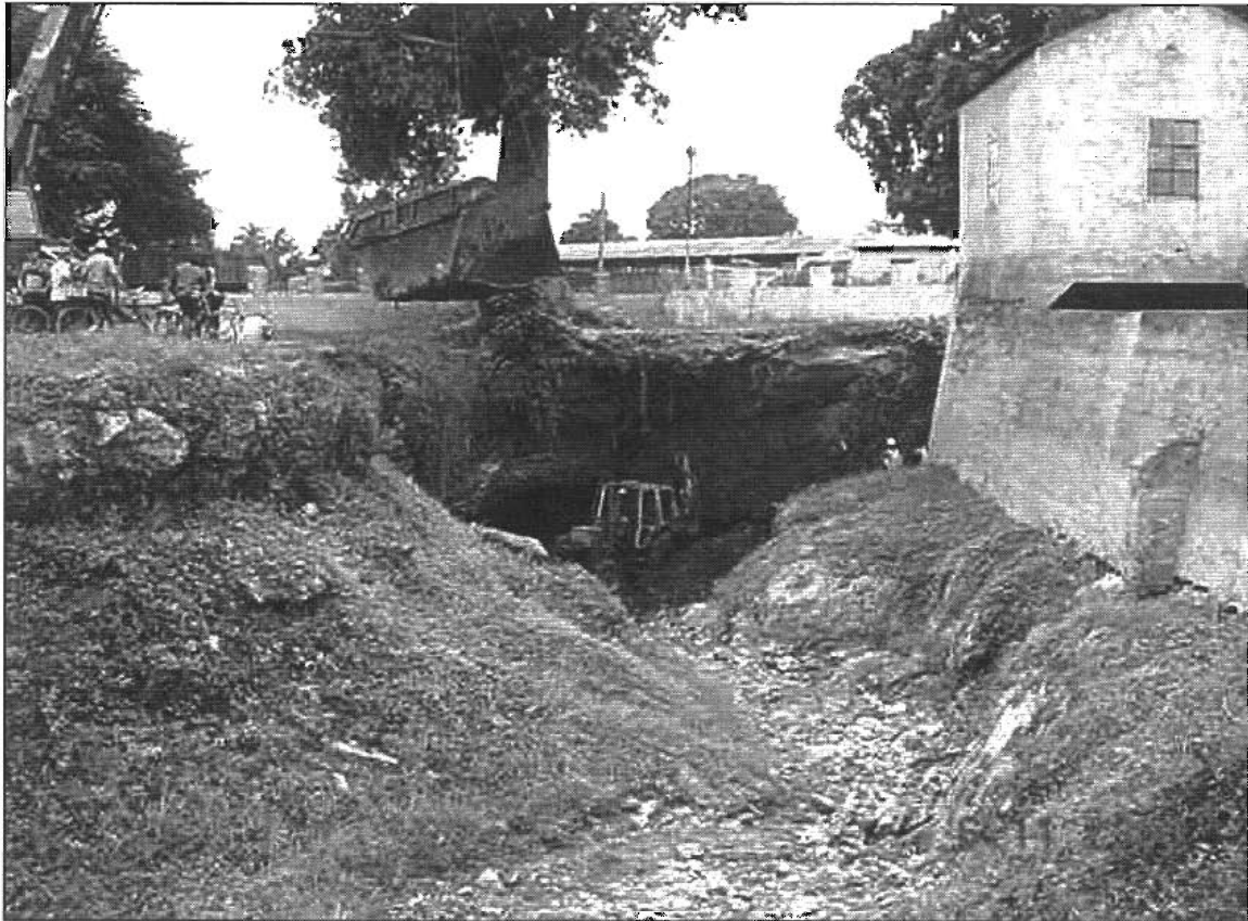
FIGURA 4. TRABAJO DE EXTRACCIÓN DE LOS SEDIMENTOS EN EL SUMIDERO
