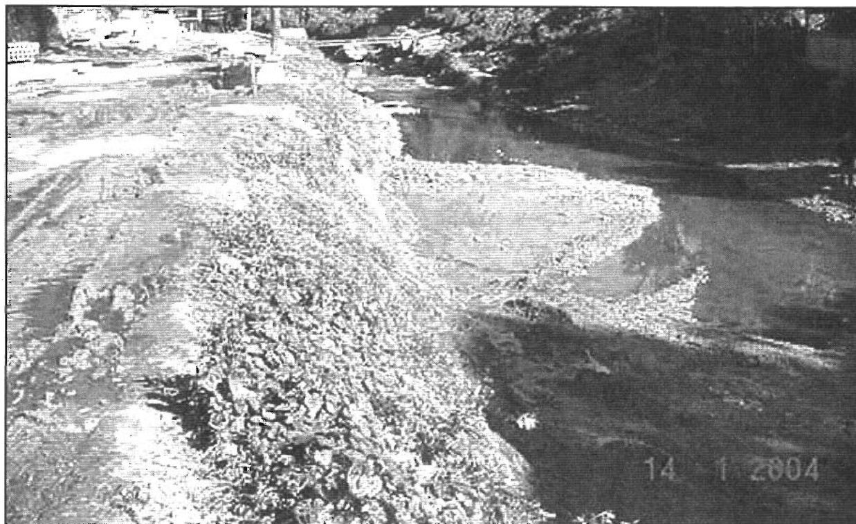
FIGURA 2. SECTOR DEL RÍO "SAN ANTONIO DE LOS BAÑOS", NÓTESE LAS LABORES DE LIMPIEZA
