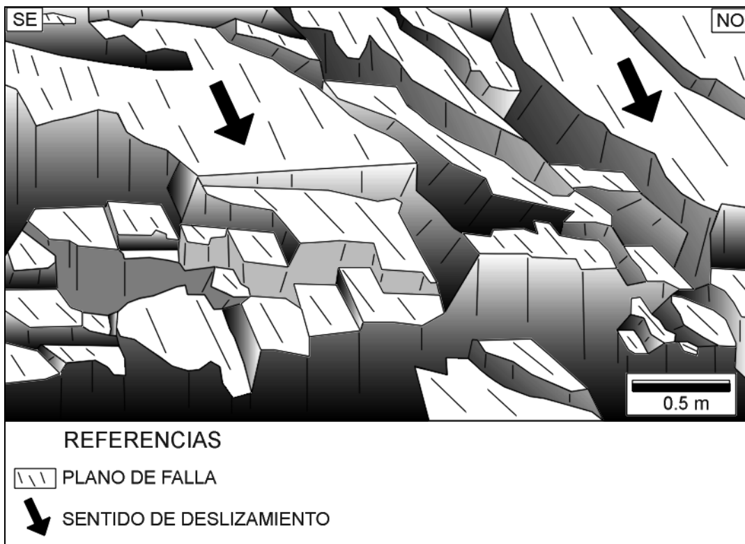
FIGURA 4: DETALLE DEL ÁREA A DE LA FIGURA 3, DONDE SE OBSERVA LA GENERACIÓN DE BLOQUES POR LA INTERSECCIÓN DE SISTEMAS DE FRACTURAS
