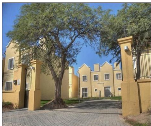
b- Tipología de vivienda en barrio Housing del Sur. Fuente: imagen propia
