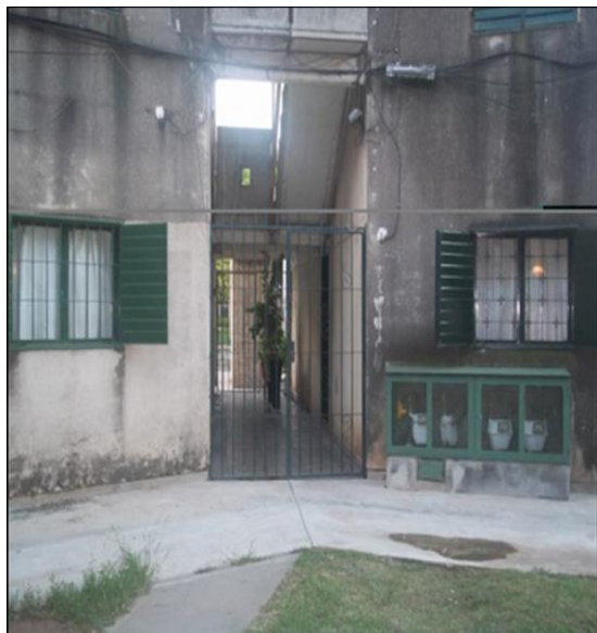
Figura N 15: imágenes de espacios internos al barrio SEP
